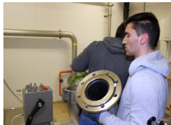
AS54 Ventil in Rohr eingesetzt
