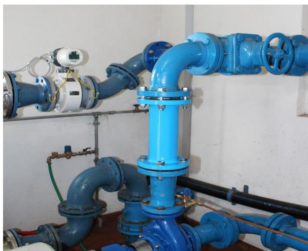
Zwischenflanschmontage des Stop Silent Ventils
