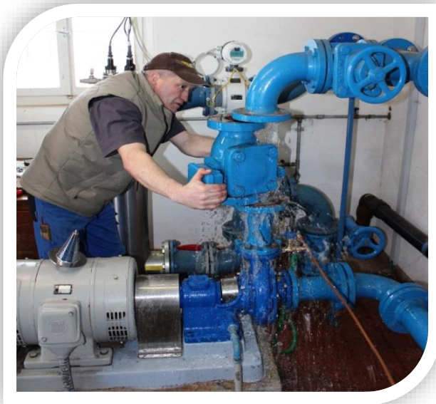
Brunnenmeister Gysin entfernt das alte Rückschlagventil
